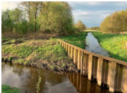
*Spundwand zwischen Boholzer Au und Oxbek mit erkennbarem Geländeunterschied*
